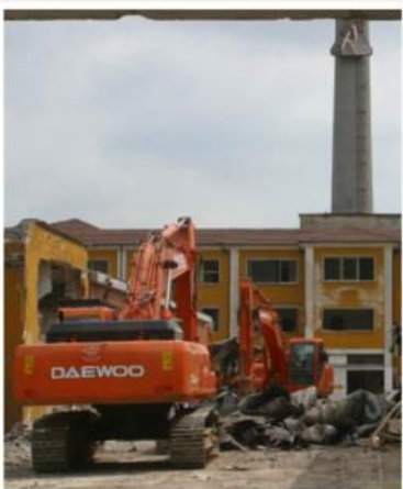
Le ruspe demoliscono lo storico Cotorossi a Vicenza
